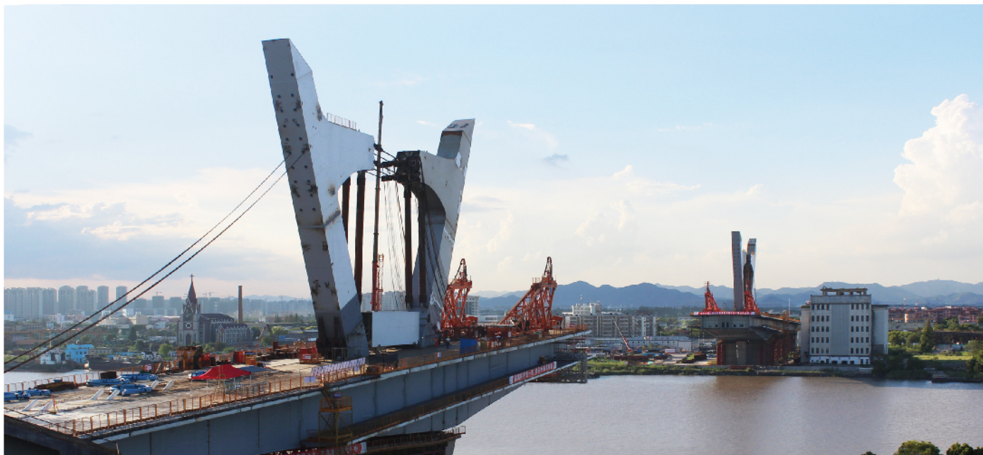
宏润投资承建宁波中兴大桥主塔竖转施工全部顺利完成
