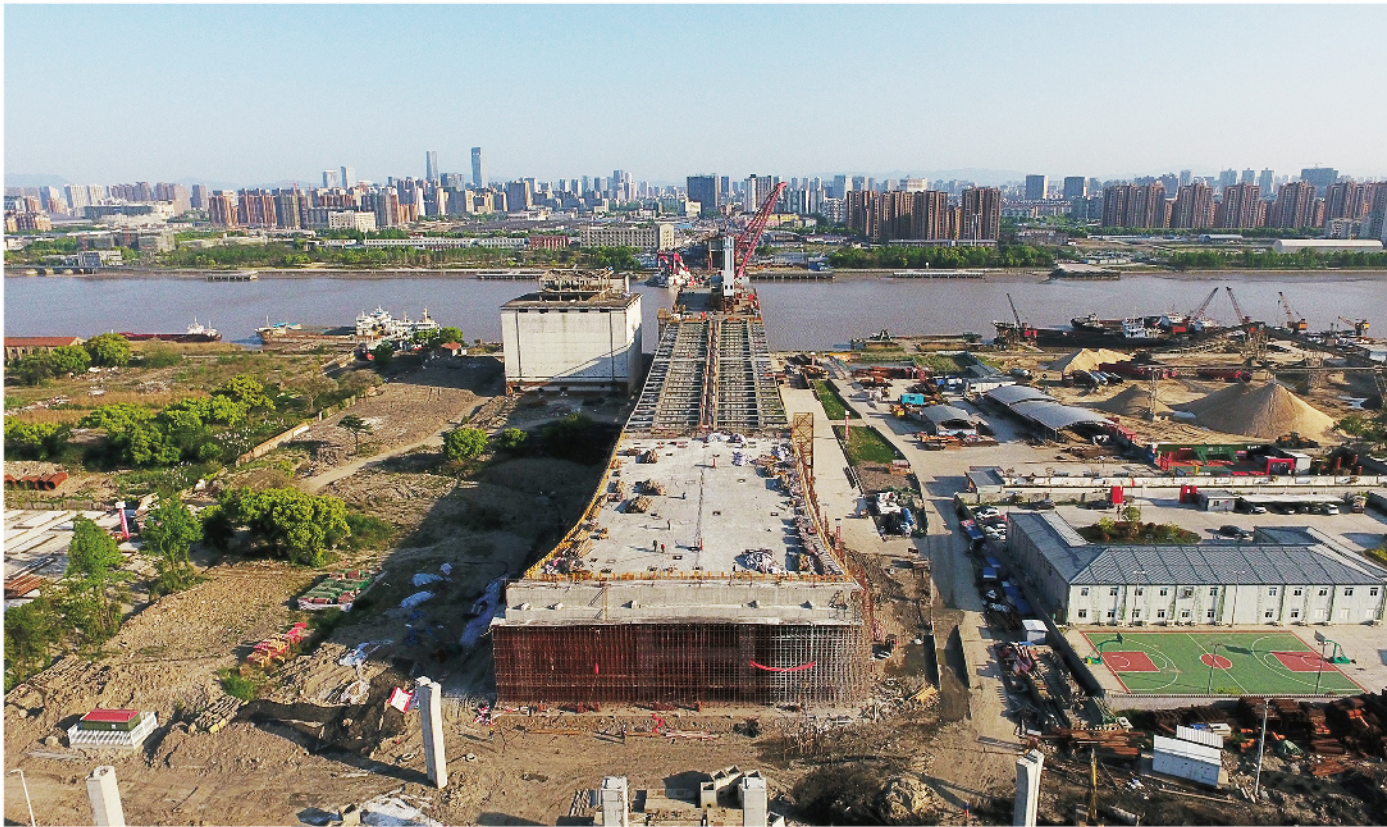
宁波中兴大桥及接线工程（总承包公司承建）
