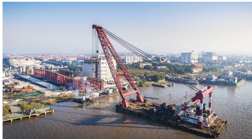
LBN16#梁段试吊
