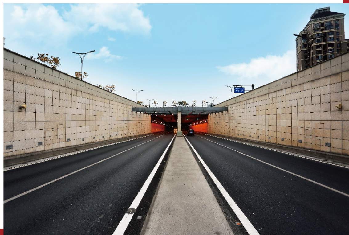
杭州市紫金港路（文一西路～留祥路）工程（杭州公司承建）
