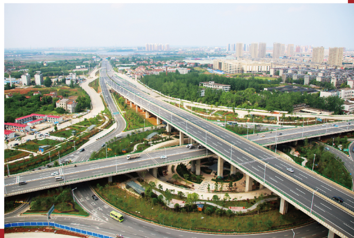
武汉市黄陂区岱黄公路刘店立交综合改造工程（总承包公司承建）
