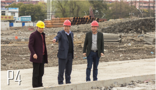
2017年3月16日，尹芳达总经理视察中兴大桥及接线项目。
