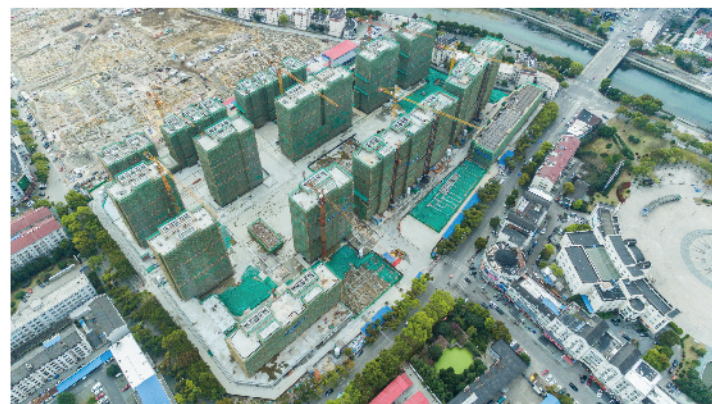
奉化惠政东路一号地块拆迁安置房
