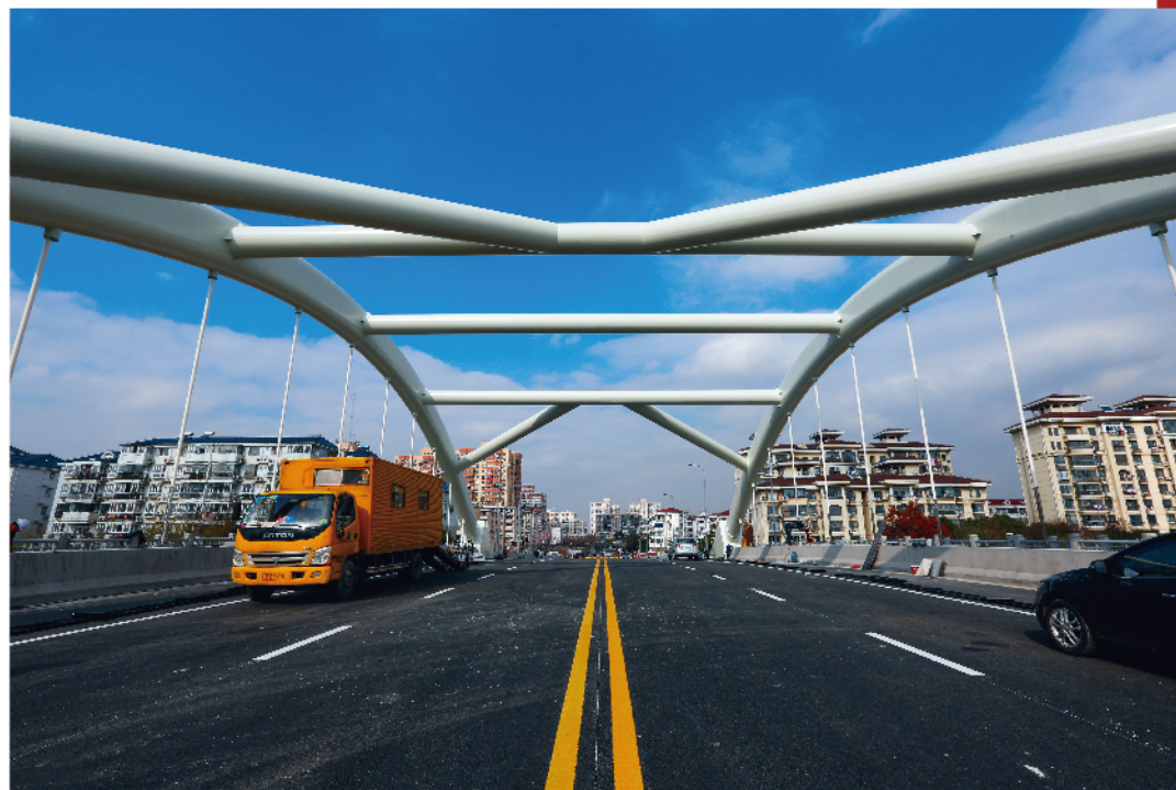
上海老沪闵路三号桥（跨淀浦河）工程（第十二项经部承建）
