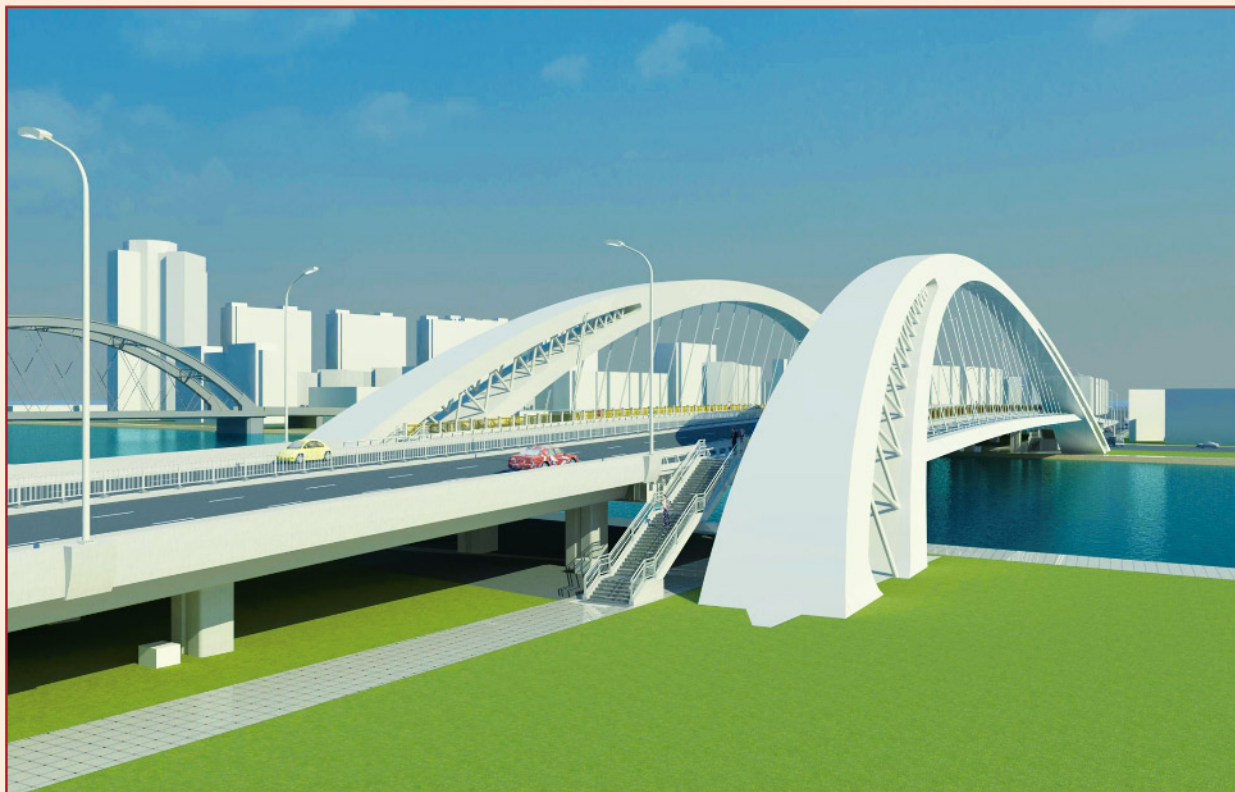
宁波市特大跨奉化江无风撑中承式内倾钢坦拱桥——澄浪桥工程 (宏润宁波公司承建)
