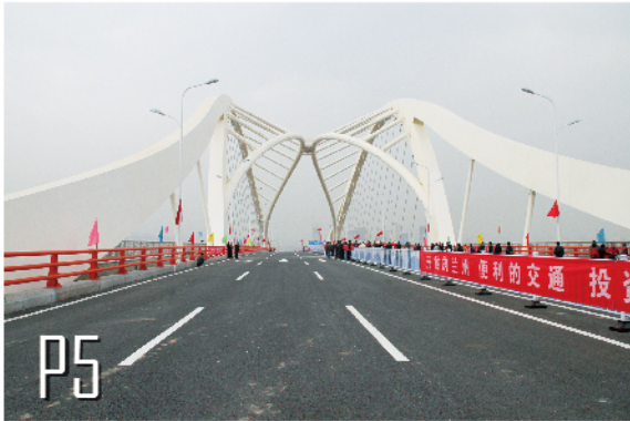
2014年9月30日，宏润兰州深安黄河大桥工程顺利建成通车。
