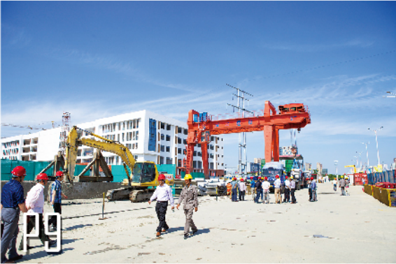
2014年5月23日，公司举办轨道交通质量安全文明施工观摩。
