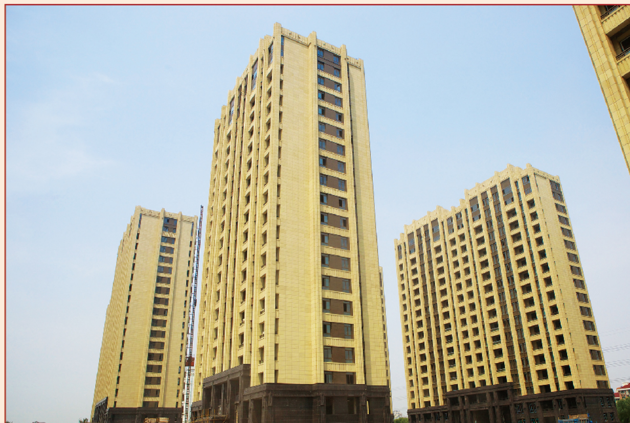
宏润承建上海万源城项目（第7项经部）
