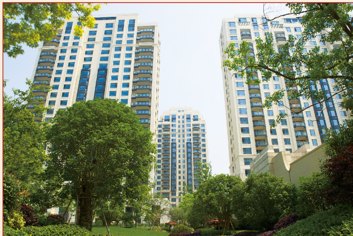
宏润承建上海雅戈尔长风8号项目（第19项经部）
